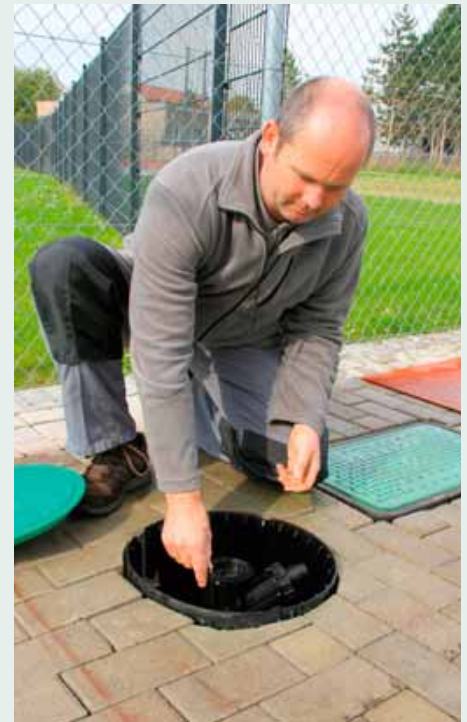
Das Inneneil lässt sich von oben herausnehmen, ohne dass der komplette Regner ausgegraben wer- den muss.
