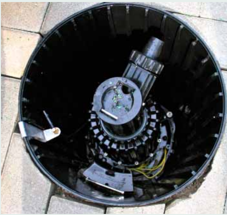
Noch einmalig in Deutschland: Der erste versenkbare ELR-Großflächenregner von Rain Bird für die Kunstrasenbewässerung wurde in Borna bei Leipzig installiert.
